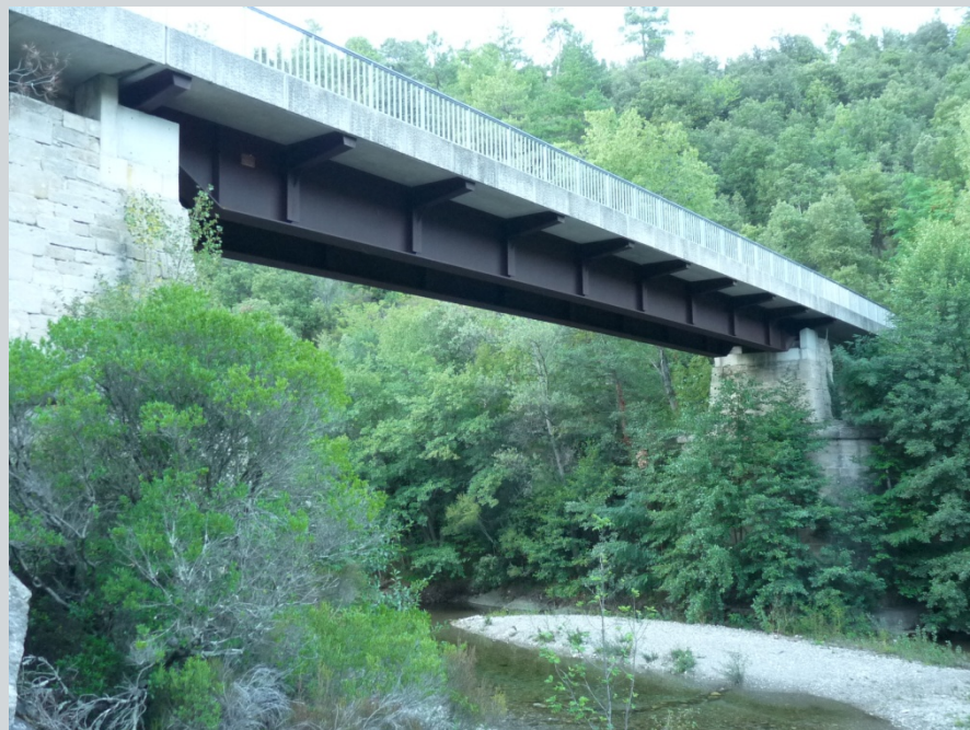
Pont de Souillas à Aujac (30)
