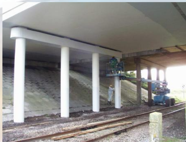
Mise en œuvre du revêtement de protection en intrados et sur appuis
