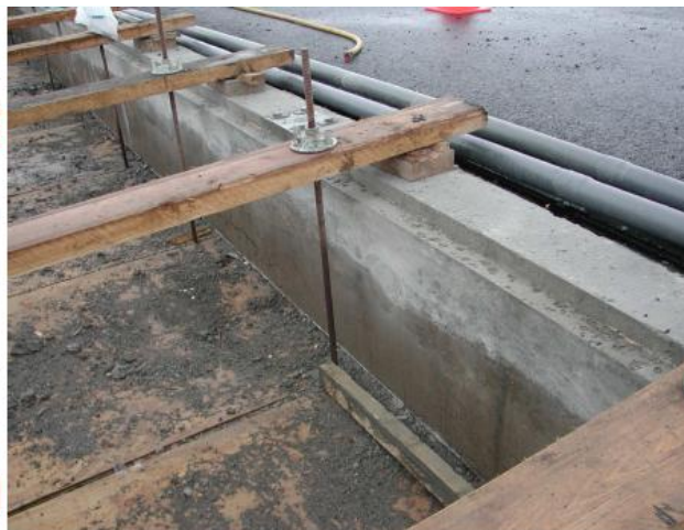
Confection d'une longrine ancrée en TPC et reprise de l'étanchéité
