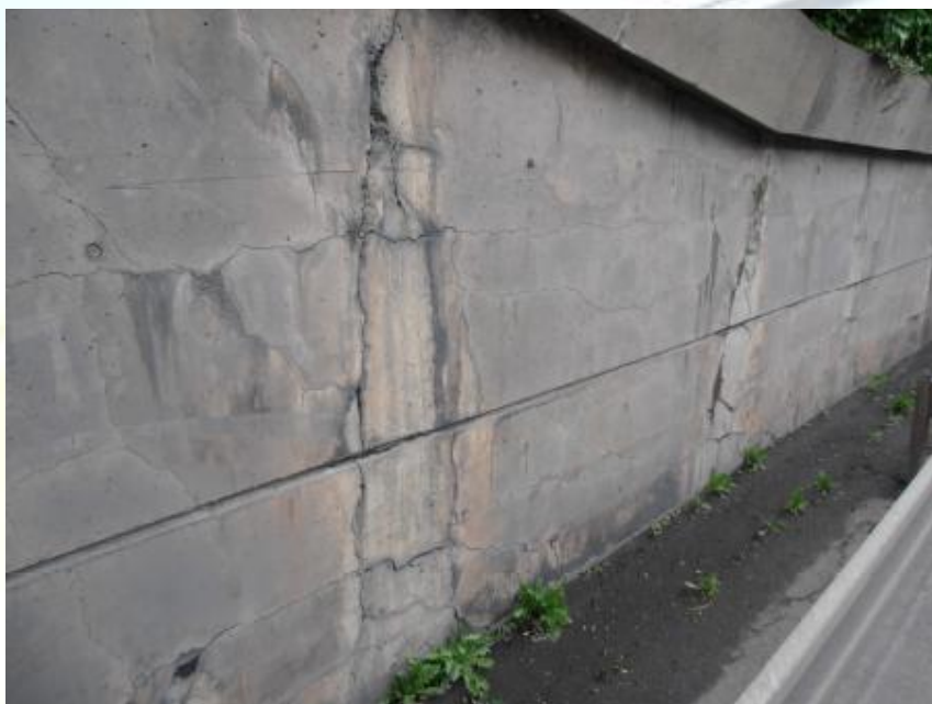
Mur en béton armé
