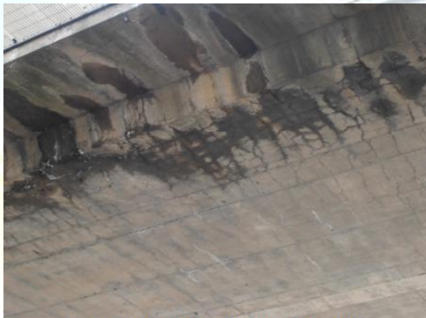
Tablier d'un pont-dalle en béton armé
