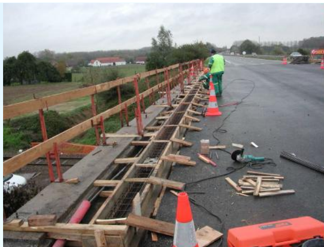
Confection d'une longrine non ancrée en rive et reprise de l'étanchéité
