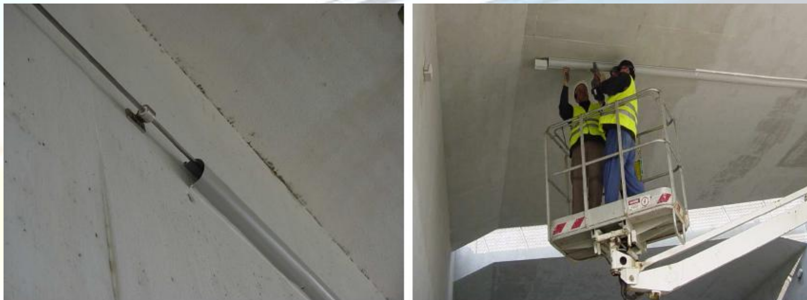
Capteurs de déplacement à liaison radio positionnés à l'extrémité de barres de 6 à 12 m de longueur
