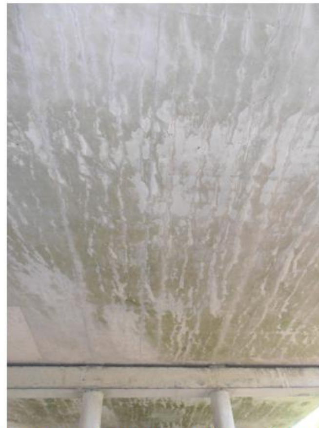
Tablier d'un pont-dalle en béton précontraint
