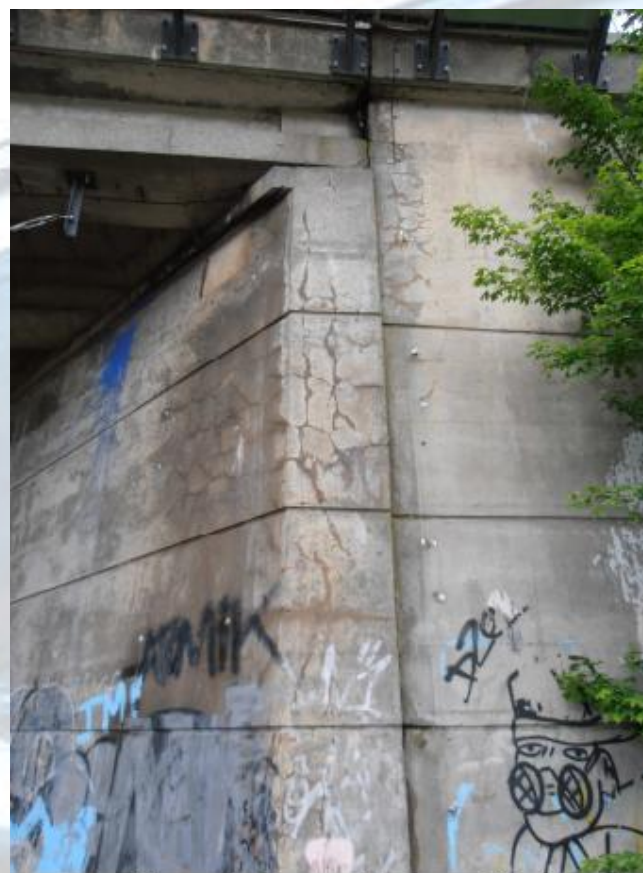
Mur de front d'une culée
